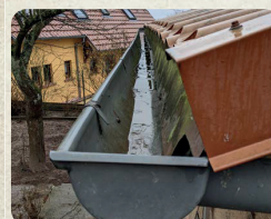
4 Nettoyer les gouttières
